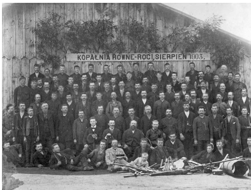
Il. 3. Pracownicy kopalni Równe – Rogi
