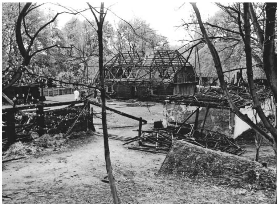
Il. 7. Chata po pożarze, 2004 r.; fot. M. Kosicki
