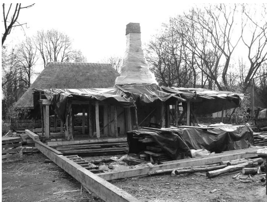
Il. 8. Chata po rozbiórce, 2004 r.; fot. E. Tyczyńska
