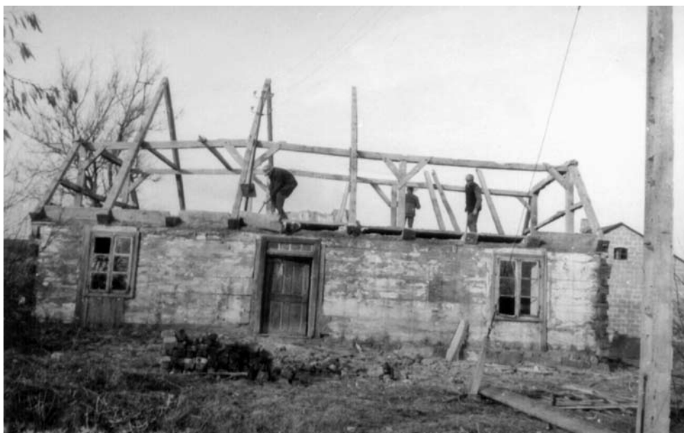
Il. 3. Chata w Rakutowie podczas rozbiórki, 1967 r.; fot. Z. Zgierun
