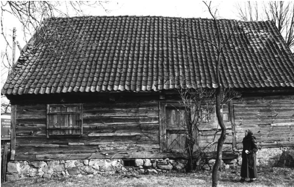
Il. 5. Mątowskie Pastwiska 30, dom dla pracowników rolnych, elewacja wschodnia, stan z 1991 r.; fot. M. Kosicki, MET, I-548-92
