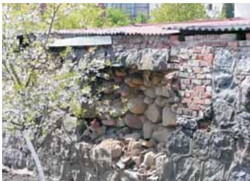
Wyraźna, dwuwarstwowa struktura muru kamiennego jest dobrze widoczna po częściowym zawaleniu się warstwy zewnętrznej. Lisiewo, gm. Gniewino, pow. Wejherowo. Fot. M. Kuklik.
