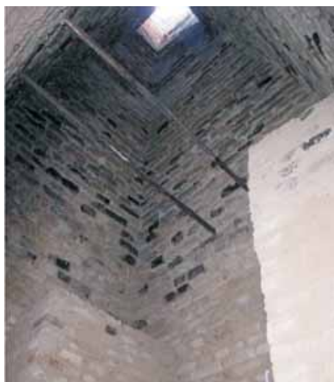
Wymurowany z pacy komin w dworku z Trzebunia w M-KPE. Fot. S. Klein.
