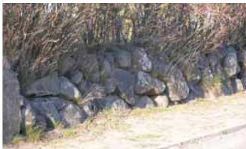
Zbierane z pola i układane na granicach i skrajach dróg kamienne murki są najprostszym sposobem wykorzystania kamieni w budownictwie wiejskim. Świecino, gm. Krokowa, pow. Puck. Fot. M. Kuklik.
