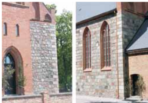
Przodkowo, gm. Przodkowo. Fragmenty konstrukcji kamienno-ceglanego kościoła z 1874-78 r. Fot. M. Hawryszków.
