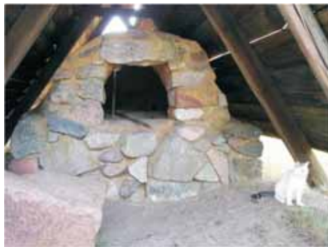
Wolnostojący kamiennieo-gliniany piec chlebowy w zagrodzie z Nakli w M-KPE. Fot. S. Klein.
