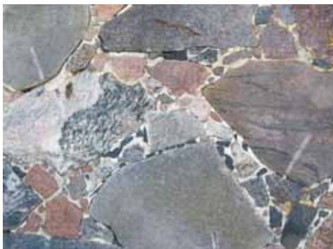
Do uszczelniania murów stosowano spoiwo, którym była najczęściej niezbyt tłusta glina zmieszana z drobnym żwirem, gdy ilość takiego spoiwa była zbyt duża, wtykano w nie drobne okruchy skalne. Finezja i dokładność wykończenia kamiennego muru, nawet w budynkach gospodarczych, może wzbudzić podziw. Stodoła w Widlinie, gm. Puck, pow. Puck. Fot. M. Kuklik.
