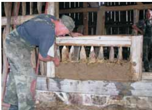
Konstruowanie muru wypełnianego z gliny w warsztacie kołodziejskim z Mirachowa przeniesionym do M-KPE. Fot. M. Hawryszków.
