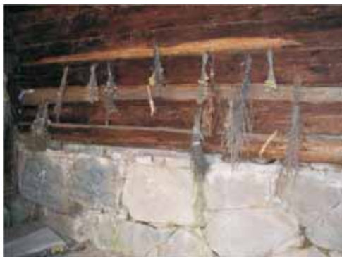
Fragment kamiennego fundamentu w budynku inwentarskim z Krosewa w Muzeum – Kaszubskim Parku Etnograficznym we Wdzydzach (dalej M-KPE). Fot. S. Klein.
