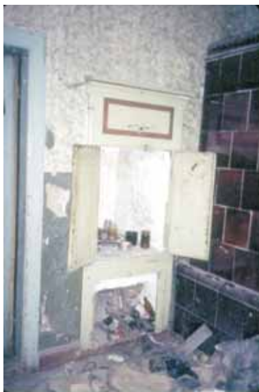
9. Cieminko nr 17 gm. Ostrowice. Chałupa z przełomu XIX/XX w., izba z kominkiem zamykanym drzwiczkami, i piecem ogrzewczym kaflowym. Fot. U. Dalska – Sienkiewicz.
