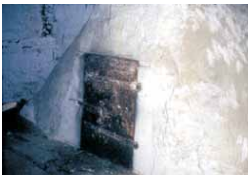
15. Bruskowo Małe nr 8 pow. Słupsk. Chałupa bezkominowa z I poł. XIX w. z wtórnie wyciągniętym kominem z suszonej cegły, widok na część szerokiego komina na poddaszu, w nim drzwi do
