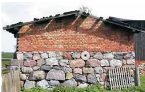
Najprostszym sposobem kamiennego budowania było układanie bloków skalnych bez użycia spoiwa. Charakterystyczną cechą takich konstrukcji jest zmniejszanie się wielkości dobieranego materiału wraz z wysokością. Obora w Sobieńcach, gm. Krokowa, pow. Puck. Fot. M. Kuklik.
