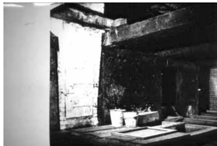
7. Dąbki nr 23 pow. Sławno. Chałupa rybacka z pocz. XIX w., bezkominowa, z wtórnie wyciągniętym przewodem dymowym; fragment komory dymowej w części poddasza, z nowszym ceglany kominem. Fot. G. Solecki.
