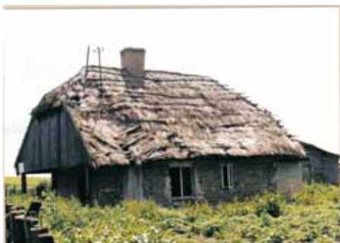
Wymurowana z pacy chałupa robotnicza w Klonówce, z ok. 1830 r. Fot. T. Sadkowski.
