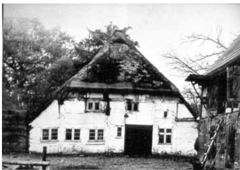
13. Krupy nr 16 pow. Sławno. Chałupa wąskofrontowa typu saskiego z 1717 r., rozebrana w latach 80. XX w; zbudowana bez komina, z wtórnie wyciągniętym przewodem dymowym o szerokiej
