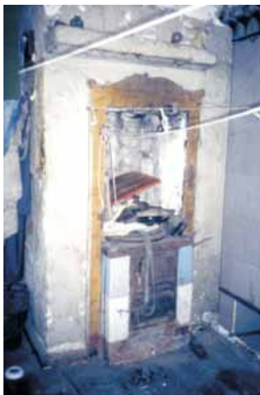
10. Smoldzęcino nr 13 gm. Ostrowice. Chałupa z połowy XIX w., kominek i piec kuchenny kaflowy z płytą żelazną do gotowania. Fot. U. Dalska – Sienkiewicz.
