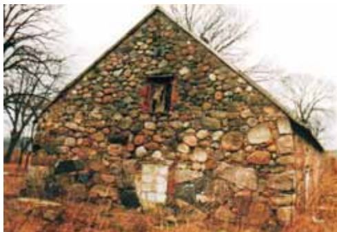
Ściany frontowe tej samej kamiennej obory. Na murze widocznym od ulicy zauważalne jest pracochłonne wykończenie szczegółów (z lewej), szczyt od strony podwórza wykonany został z mniejszą dbałością (powyżej). Obora w Opalinie, gm. Gniewino, pow. Wejherowo. Fot. M. Kuklik.
