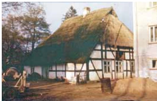
5. Dąbki nr 22 pow. Sławno. Chałupa rybacka z pocz. XIX w., bezkominowa, z wtórnie wyciągniętym przewodem dymowym, przeniesiona na posesję muzealną w Koszalinie w latach 80. XX w. Fot. Grzegorz Solecki.
