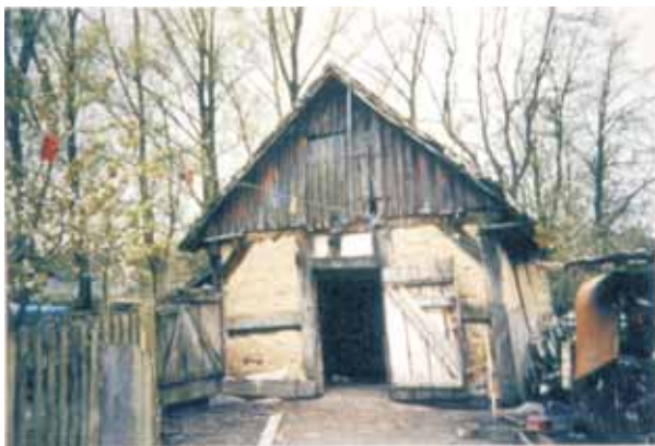
11. Starkowo nr 46 gm. Ustka. Budynek piekarniczy z I poł. XIX w., elewacja frontowa szczytowa, brak pieca piekarskiego. Fot. U. Dalska – Sienkiewicz.
