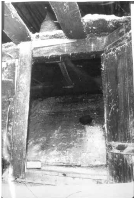
14. Krupy nr 16 pow. Sławno. Chałupa wąsko-frontowa typu saskiego, bezkominowa; fragment poddasza z wtórnym kominem o szerokiej podstawie, z cegły suszonej. Fot. G. Sołdecki.
