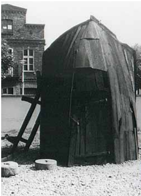
Znajdujący się w plenerowej ekspozycji Muzeum Rybołówstwa w Helu składzik rybacki z Wierchucina zbudowany z dwóch części przepołowionej łodzi tzw. pomeranki . Fot. R. Klim, 1978 r.
