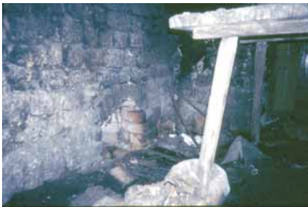
8. Cieminko nr 17 gm. Ostrowice. Chałupa z przełomu XIX/XX w., wnętrze szerokiego komina – otwór paleniska pieca ogrzewczego w izbie i fragment przewodu wyprowadzającego dym z kominka. Fot. U. Dalska – Sienkiewicz.
