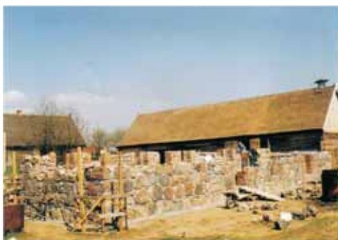
Odbudowa na terenie M-KPE kamiennego chlewa z Czarnej Dąbrowy. Fot. M. Hawryszków.
