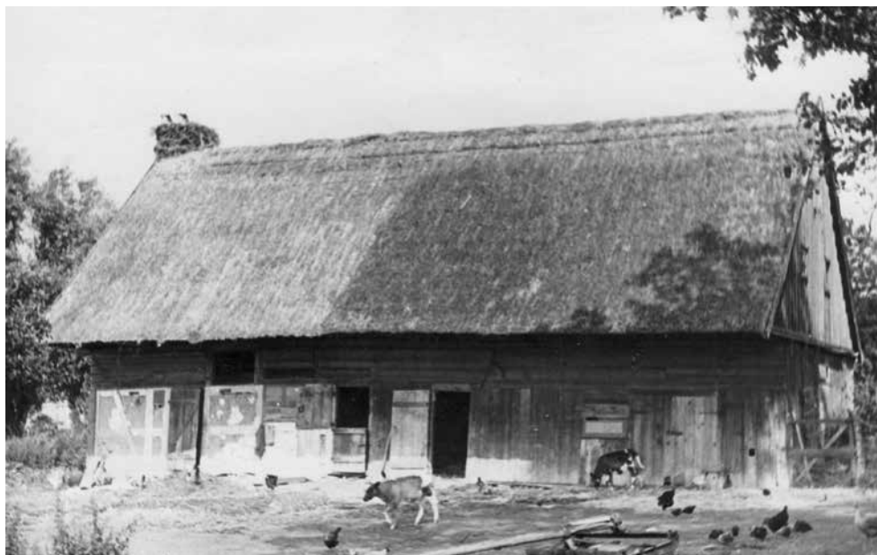
7. Budynek w konstrukcji szkieletowej z wypełnieniem mieszanym (szachulec, szalunek), Kwietniewo, gm. Pasłęk, pow. elbląski; fot. Franciszek Kolonowski, archiwum MBL-PE w Olsztynku
