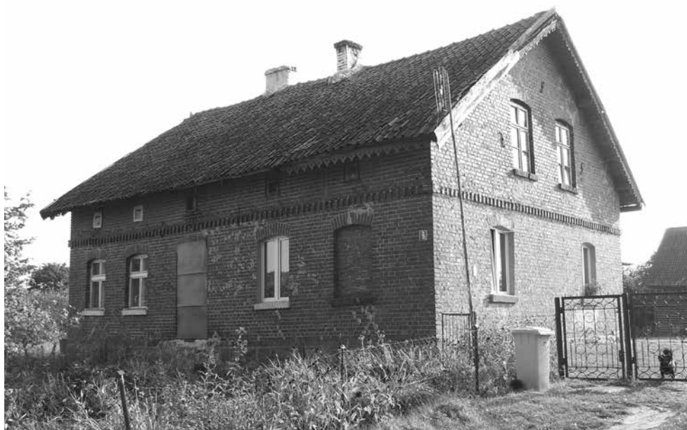
8. Budynek z czerwonej cegły, Jemiółowo; fot. Michał Poniewski, archiwum MBL-PE w Olsztynku
