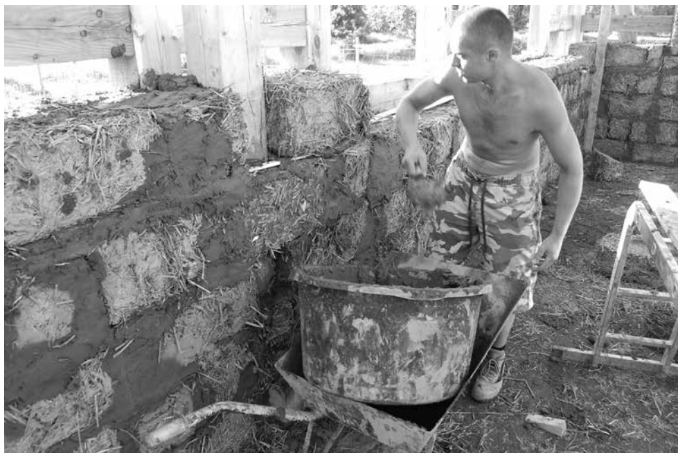
8. Wypełnianie ściany szkieletowej bloczkami gliniano-słomianymi, Modła, 2008 r.; fot. Dawid Gonciarz
