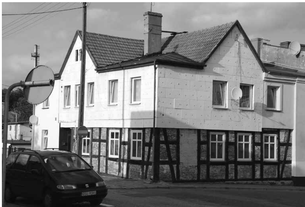
12. Ocieplanie konstrukcji szkieletowej styropianem, Ustka, 2011 r.; fot. Dawid Gonciarz
