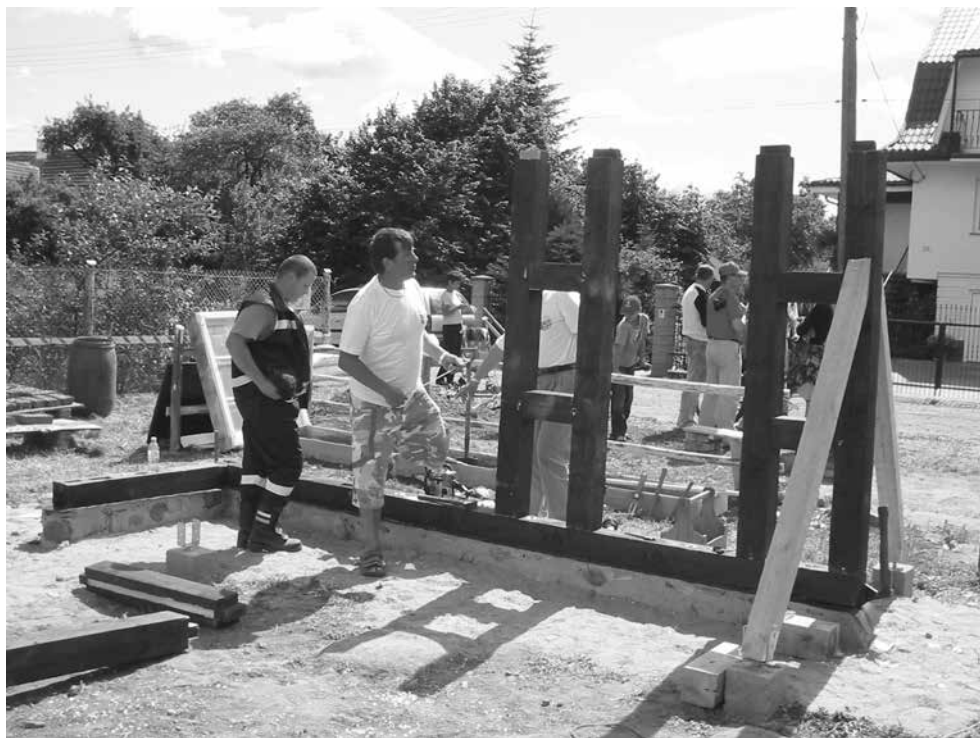
5. Stawianie pokazowej ściany szkieletowej, Słowo, 2006 r.; fot. Dawid Gonciarz
