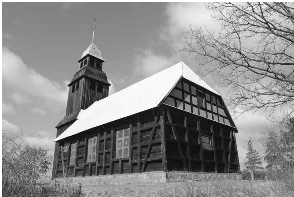
1. Kościół w Nowych Dworach, elewacja południowa i wschodnia, 2011 r.; S. Jaraczewski, Analiza stanu zachowania...
