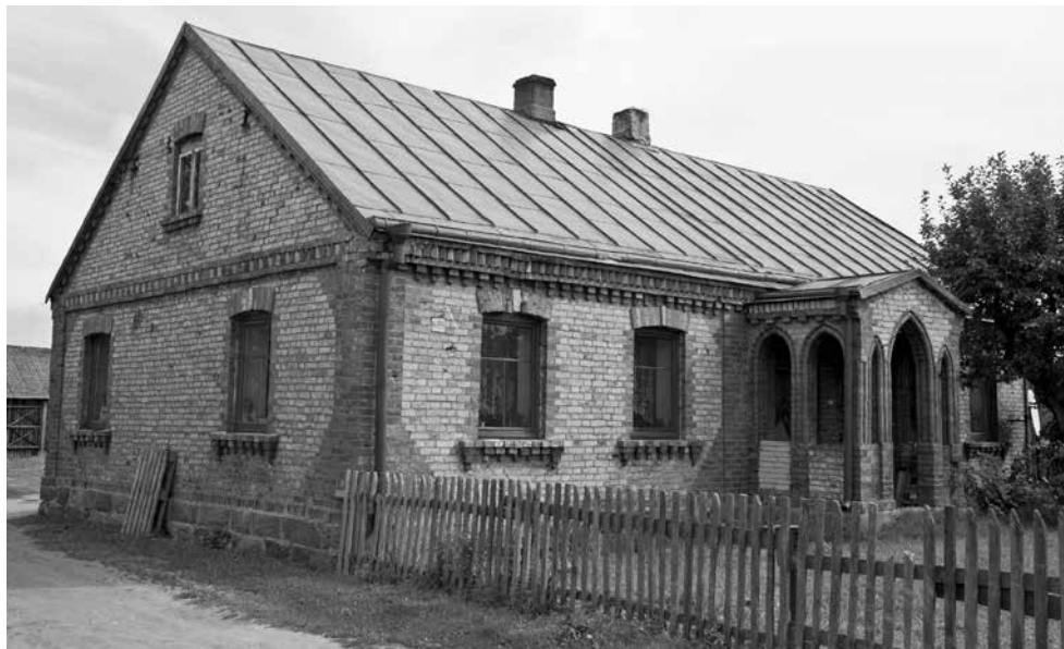
8. Murowany dom z gankiem, Jeńki, gm. Sokoły, 2011 r.; fot. Artur Gawel
