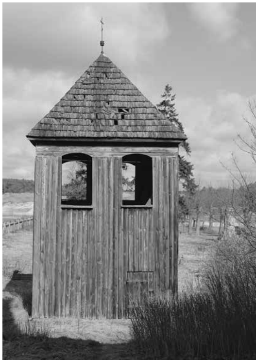
2. Kościół w Nowych Dworach, dzwonnica przykościelna – widok ogólny, 2011 r.; S. Jaraczewski, Analiza stanu zachowania...
