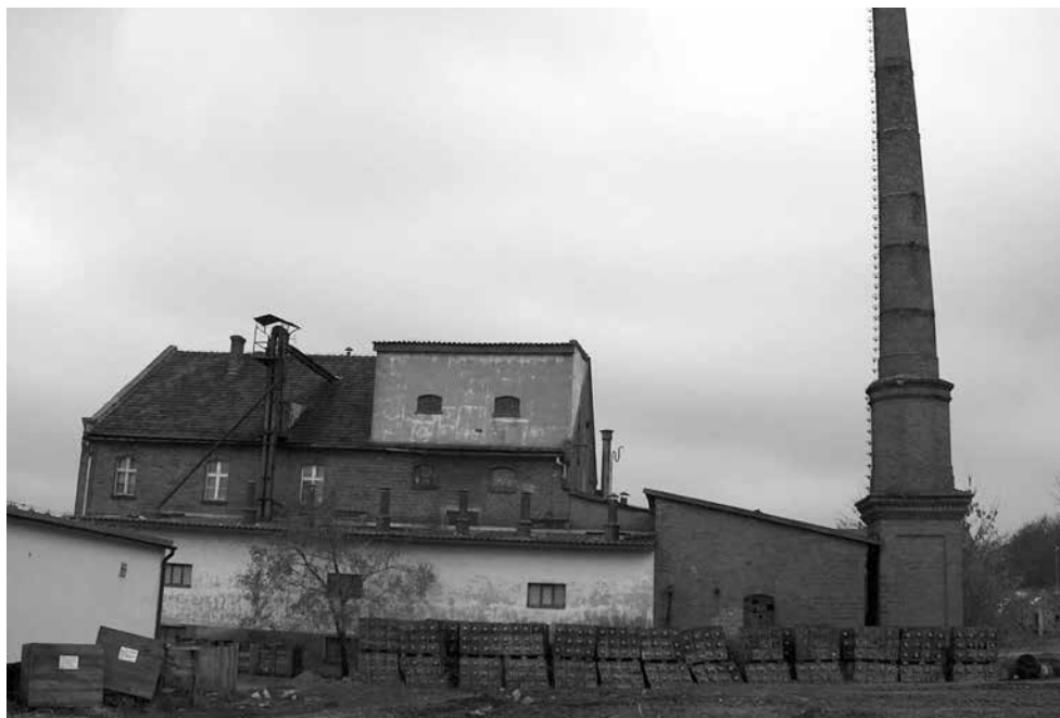
1. Widok ogólny gorzelni w Szreniawie od strony południowo-wschodniej przed adaptacją, stan z 2007 r.; fot. Zbigniew Antczak, archiwum MN RiPRS w Szreniawie
