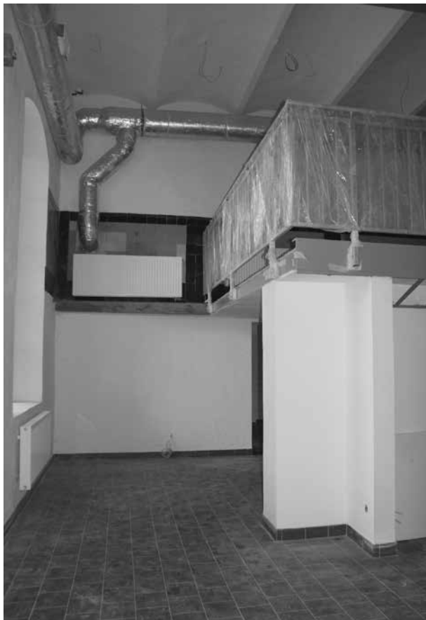
5. Pomieszczenie dawnej aparatuwni w trakcie prac budowlanych, stan z 2012 r.; fot. Anna Grześkowiak-Przywecka, archiwum MNRiPRS w Szreniawie
